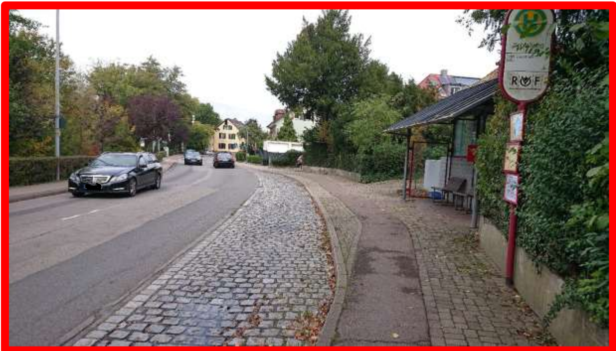
44. Enge, Bushaltestelle, schlechter Fahrbahnbelag
