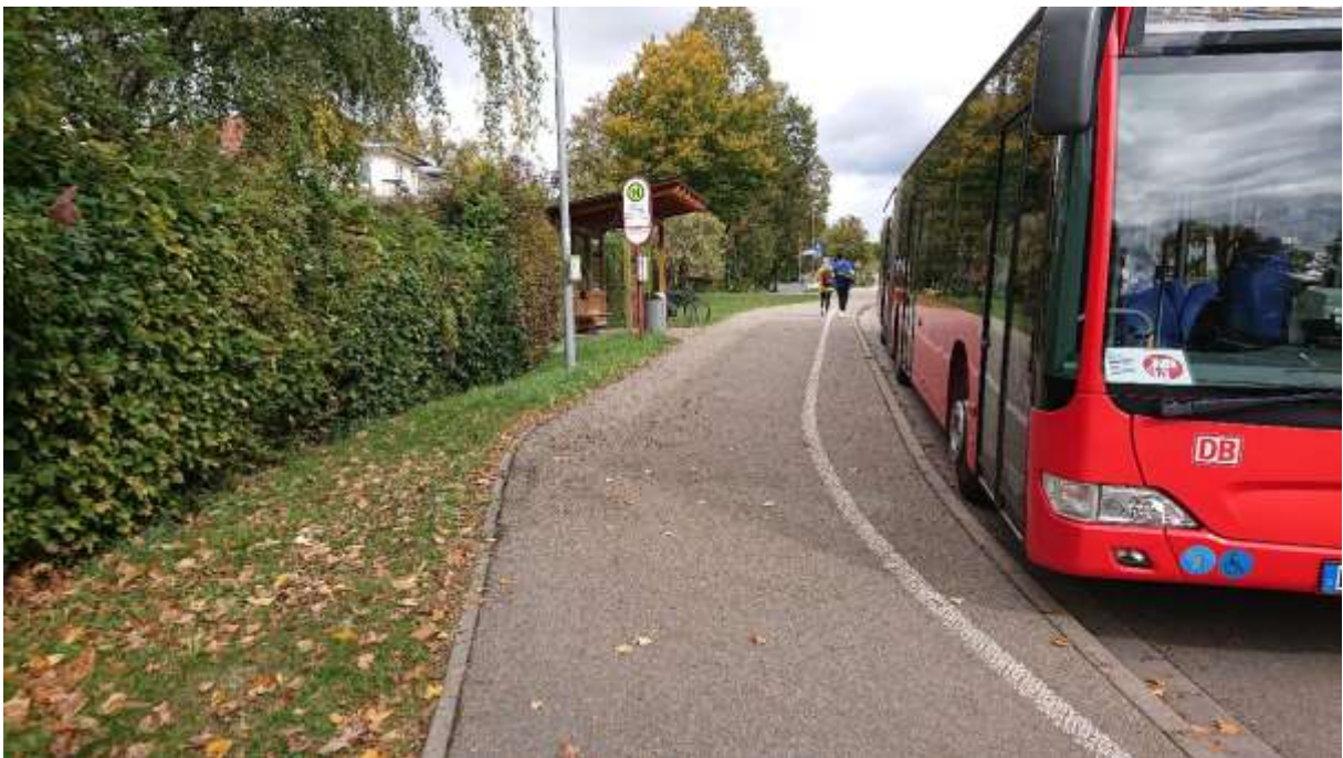
24. Bushaltestelle mit Fahrradweg in beide Richtungen
